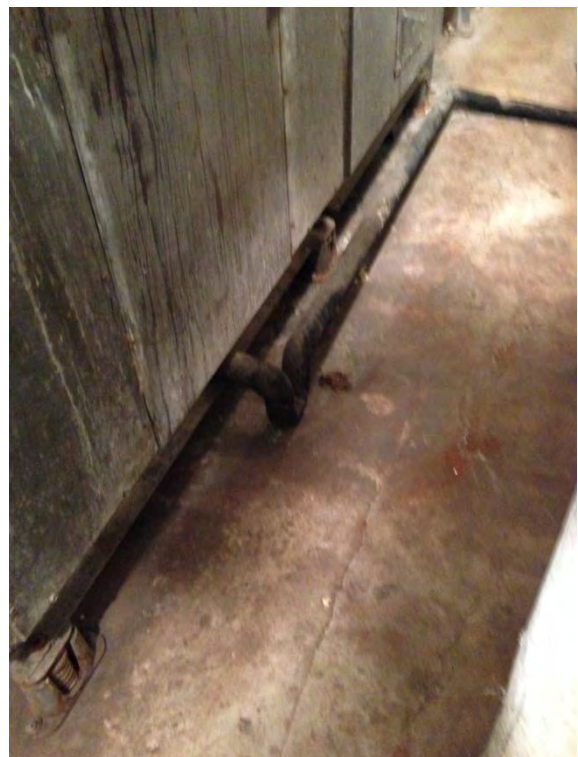
M4 – Level 5 condensate p-trap
